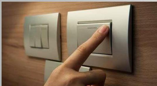
Gli **interruttori** sono dispositivi elettrici in grado di interrompere un circuito elettrico. Quando l'interruttore consente il passaggio della corrente si definisce chiuso, quando invece il passaggio della corrente è impedito, si definisce aperto.
