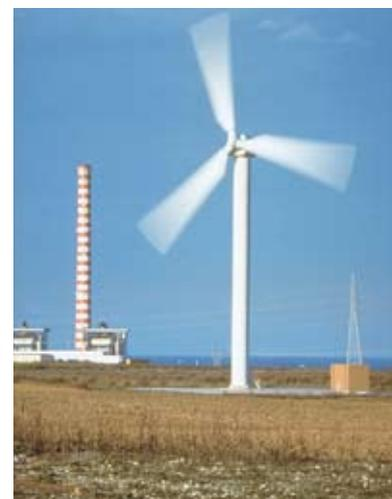
Lo sfruttamento dell'energia eolica per produrre elettricità può avvenire solo in zone in cui vi sia un vento costante e di una certa forza (tra i 10 e i 70 km/h; non oltre, perché è pericoloso); per ottenere una quantità di energia elettrica pari a quella di una normale centrale elettrica occorrono moltissimi aerogeneratori. Sono questi i principali motivi per cui l'utilizzo dell'energia eolica per la produzione di elettricità risulta ancora piuttosto limitato.
