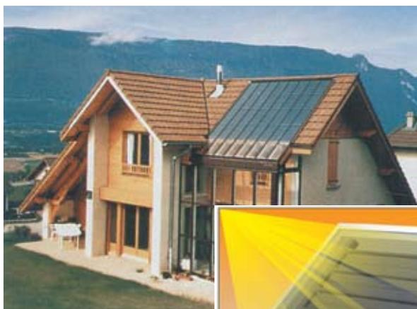
Schema di un pannello solare per la produzione di acqua calda: l'acqua fredda entra nel pannello e percorre numerosi e sottili tubi, entro i quali viene riscaldata dai raggi solari. L'acqua calda così prodotta viene poi trasferita all'interno dell'abitazione.
